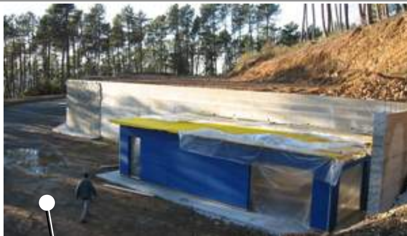
Lo sbancamento e i fabbricati della nuova scuola di Pianca
