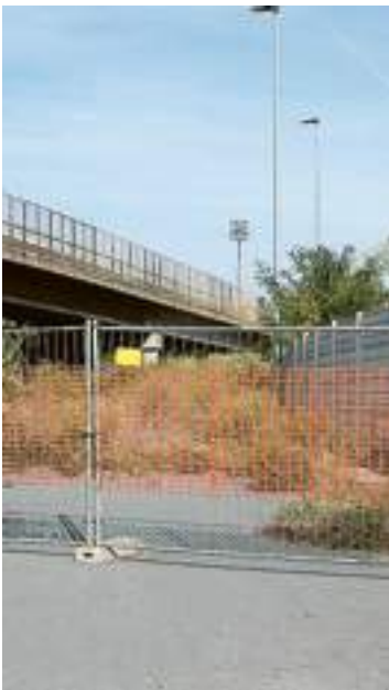
Lo svincolo di via Ferraris
