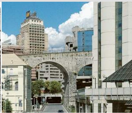
Le torri del Centro dei liguri (a destra) dov'era via Madre di Dio
