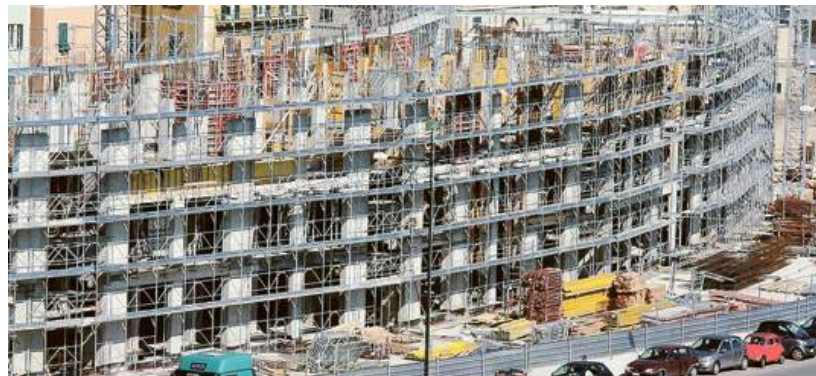
Il «Crescent», mega edificio attualmente in costruzione nella vecchia darsena di Savona
