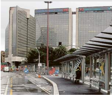
Le torri di Corte Lambruschini davanti alla stazione Brignole
