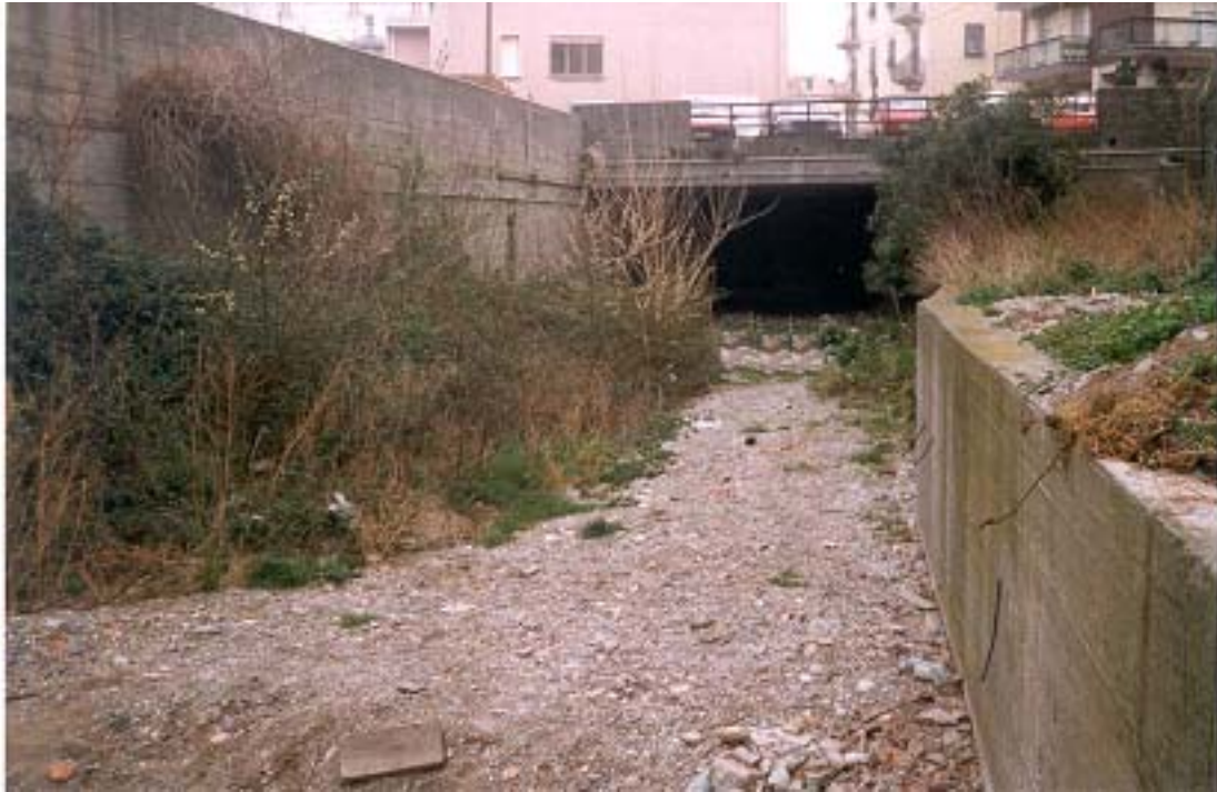
Imbocco copertura del parco ferroviario
