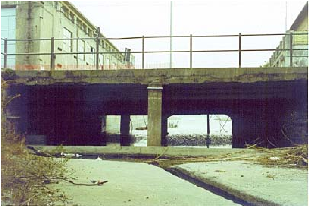
Foto 1: Ponte dell' Aurelia da monte
