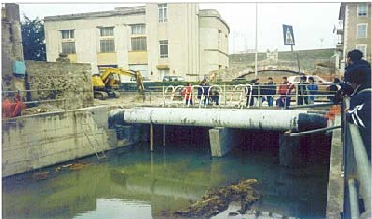
Foto 2: Ponte dell' Aurelia da valle
