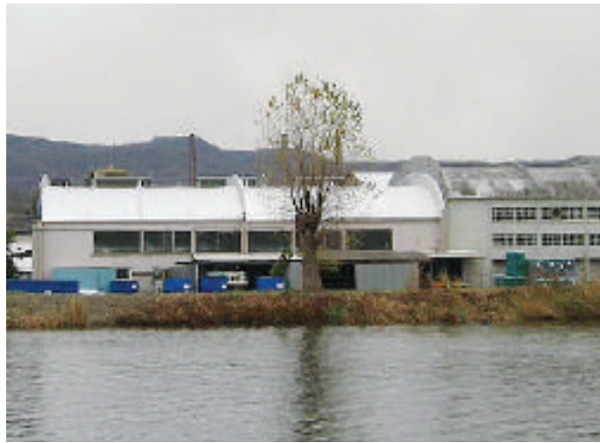
L'ex stabilimento dell'Agrimont nella zona di Cairo Montenotte
