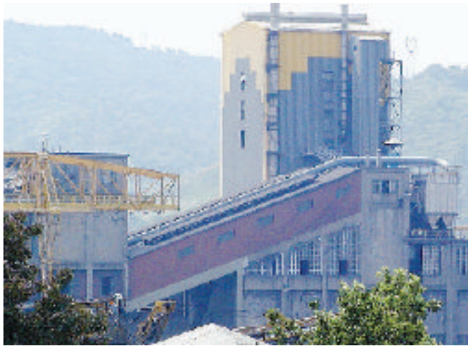
Lo stabilimento dell'Italiana Coke oggetto delle indagini
