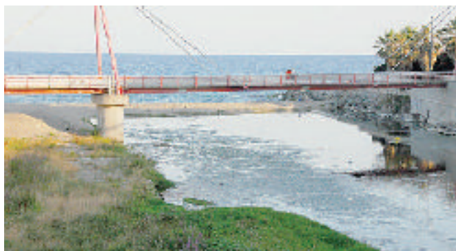
Ieri ha preso il via l'intervento di bonifica della foce del Letimbro
