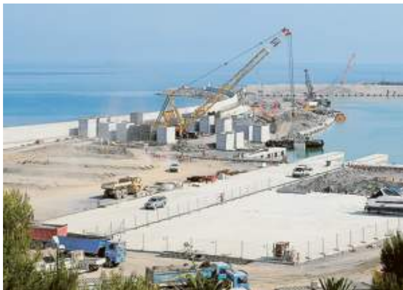
I lavori per il nuovo maxi-porto di Imperia
