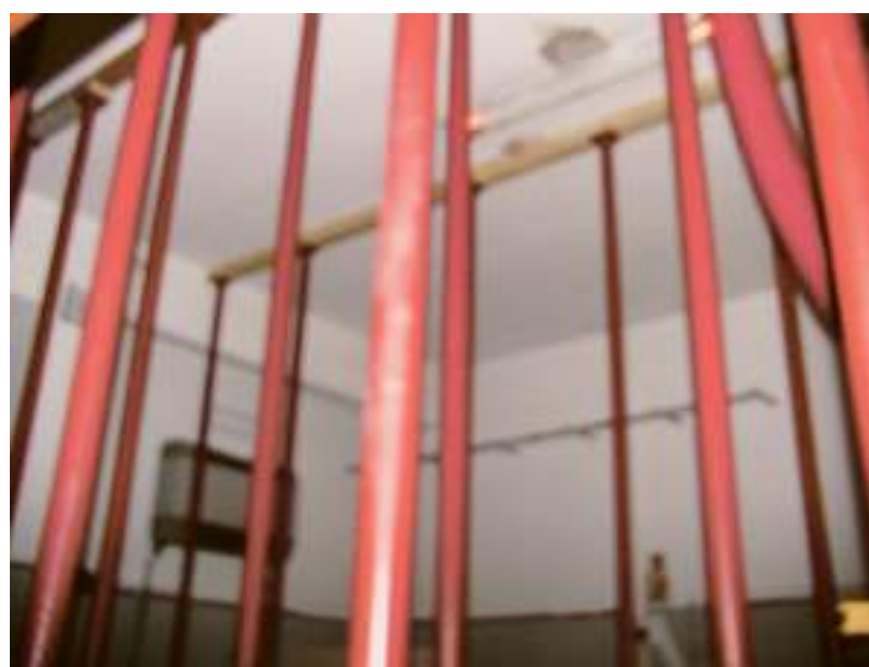
I trenta pali di supporto sistemati per sorreggere il peso della Tac
