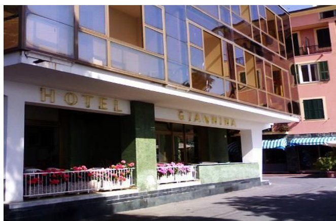
L'Hotel Giannina prima dei lavori in corso
