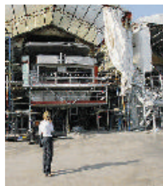
Il cantiere Baglietto di Varazze
