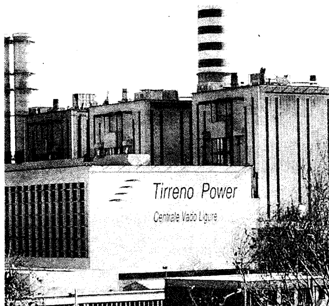
Tirreno Power intende potenziare la centrale termoelettrica
