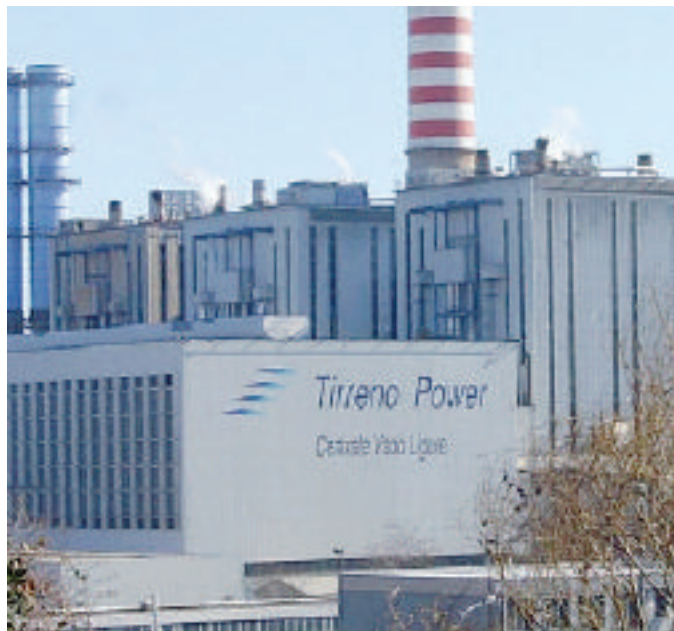
Tirreno Power intende potenziare la centrale termoelettrica
