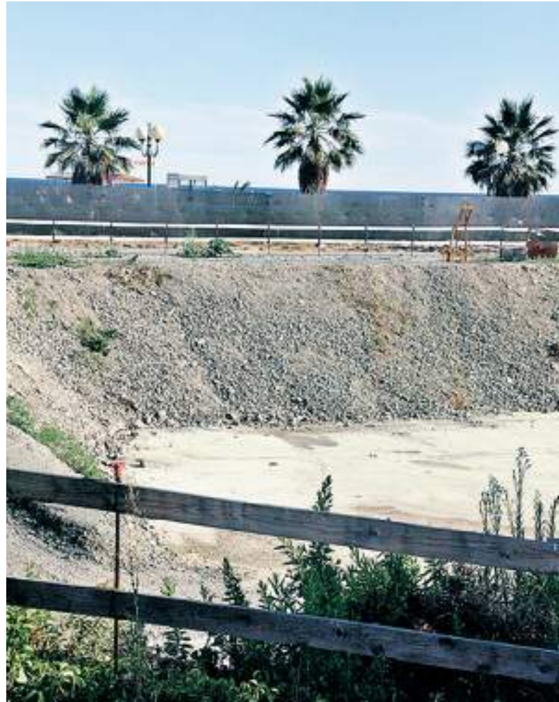
Lo scavo della piscina di corso Colombo
