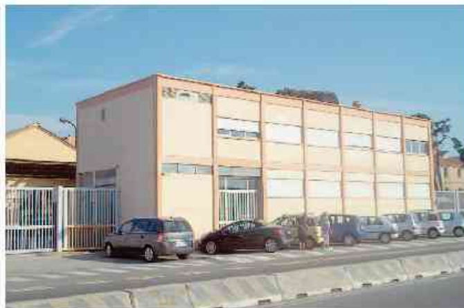
L'ex stabilimento Siad, per la produzione di gas tecnici
