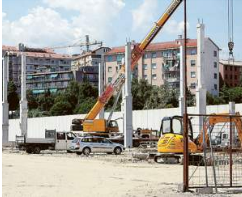
Il cantiere di parco Doria
