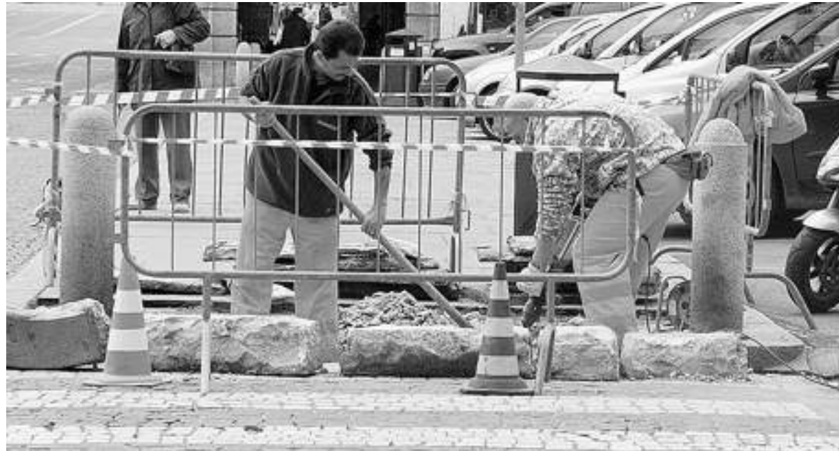
Operai lavorano alla rimozione dei gradini del marciapiede di piazza Mameli
